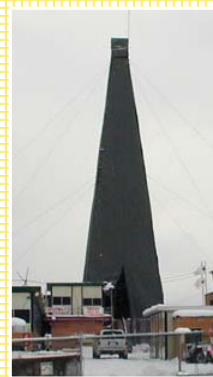
ボーリング調査風景
