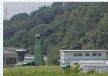
ボーリング調査風景
